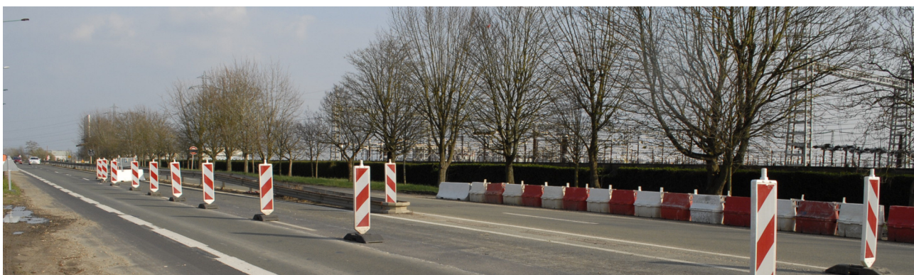
Vue rapprochée du poste depuis la RD 14.
