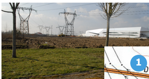
2- A l'ouest du poste : des espaces en travaux.
