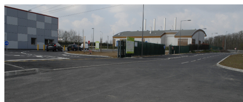
6- Immédiatement à l'est du poste : la déchetterie et la chaufferie Cyel.
