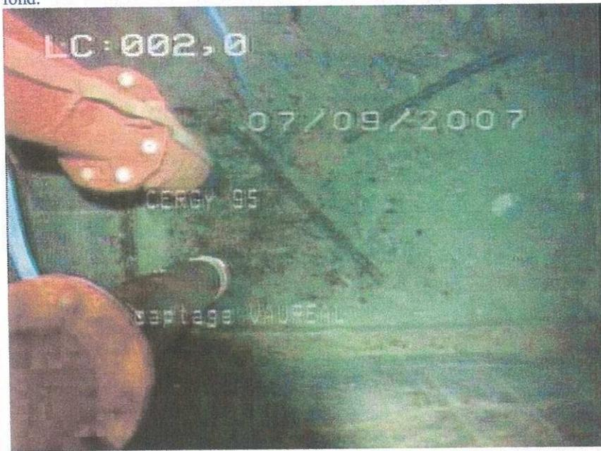
2,1 m : Observation dans l'axe du captage. Dépôts de gravier de fond, réglette de protection de sonde.
