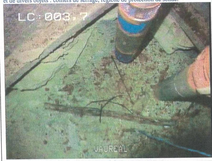
4,0 m : Vue rapprochée du fond du captage. Les deux pompes d'exploitation : la grille d'une des pompes présente des dépôts d'oxydes de fer. Bloc de calcaire sous les parois du captage.
