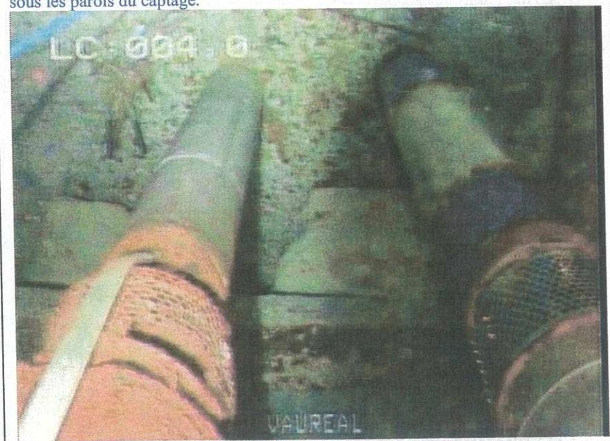
5,1 m : Observation d'un bloc de calcaire désolidarisé sous la paroi du captage (vue renversée).
