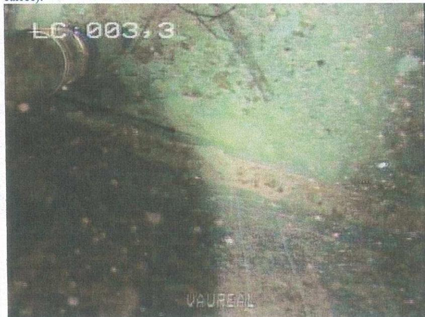
3,7 m : Vue plongeante du fond du captage. Légers dépôts constitués de graviers et de divers objets : colliers de serrage, réglette de protection de sonde.
