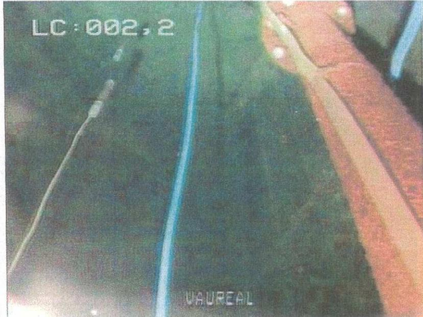
3,3 m : Parois du captage propres et en bon état (structure béton de section carrée).
