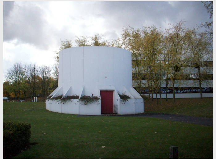
Figure 25 : Site de géothermie sur le Parc Saint Christophe (forage 01527X0130) (28/10/08)
