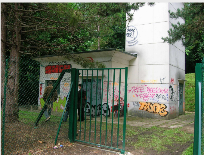
Figure 4 : Vue de l'extérieur de la parcelle du captage de Vauréal (05/07/07)
