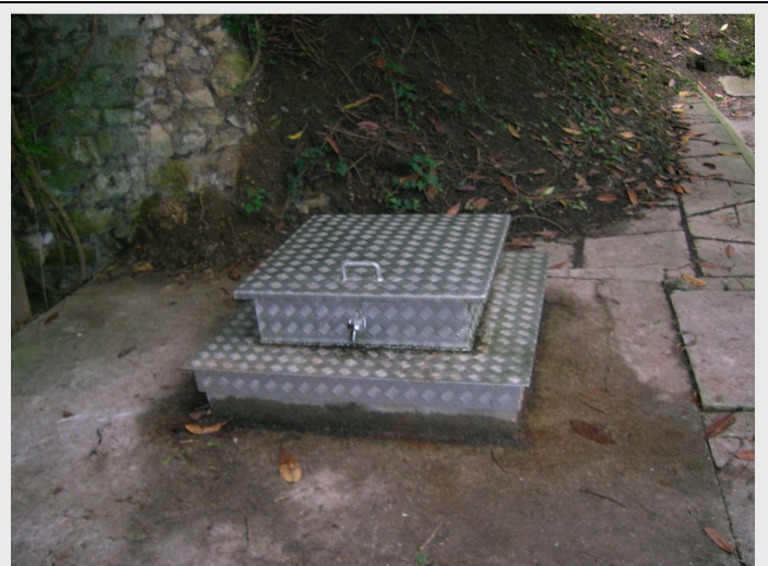
Figure 6 : Tête de captage (05/07/07)
