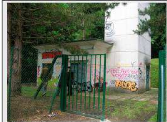
Figure 4 : Vue de l'extérieur de la parcelle du captage de Vauréal (05/07/07)
