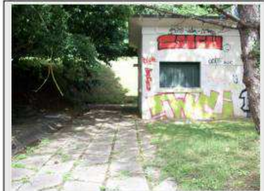
Figure 5 : Vue du fossé bétonné adjacent au local technique (10/07/08)
