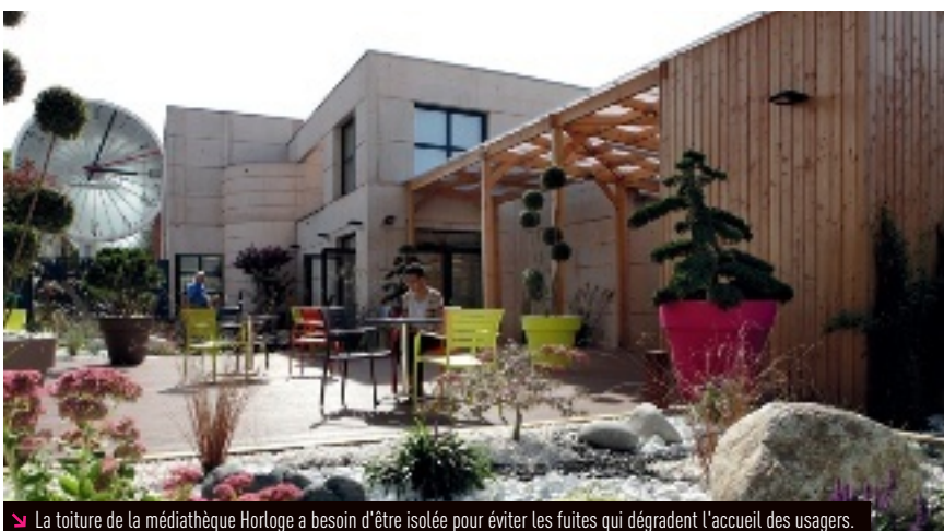
➤ La toiture de la médiathèque Horloge a besoin d'être isolée pour éviter les fuites qui dégradent l'accueil des usagers.
